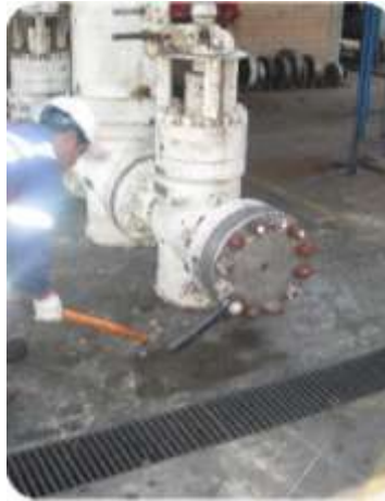
Fig. 11 - Práctica de torque incorrecta
