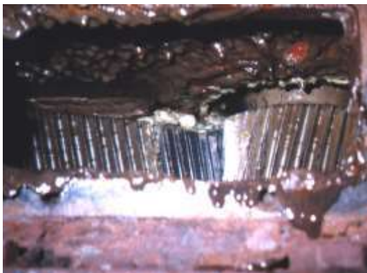
Fig. 3 - Caja de engranajes con falla por falta de lubricación
