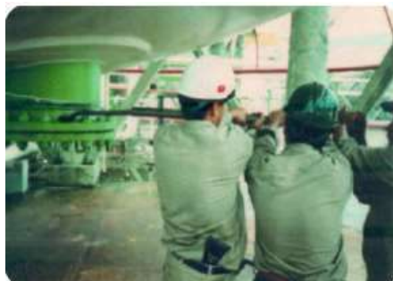
Fig. 12 - Práctica incorrecta de torque
