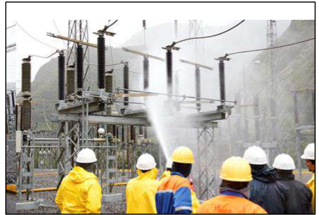
Fig 3. Lavado de aislamiento equipos de patio
