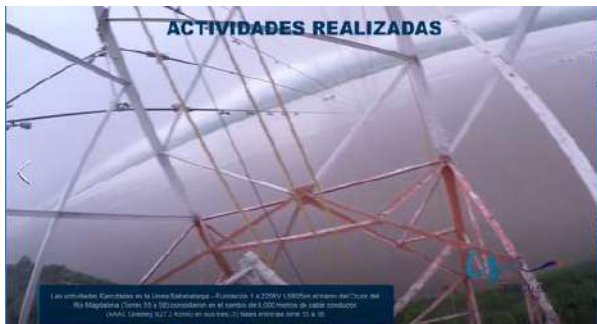
Gráfica 11. Mantenimiento de estructura de 104 metros de altura, con circuitos a 220kV Y 110kV, en cruce del río Magdalena.
