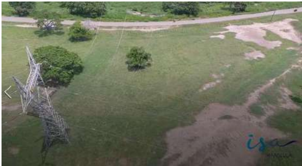
Gráfica 10. Foto real de la conexión entre la línea 816 y 805 entre torres 177 y 101
