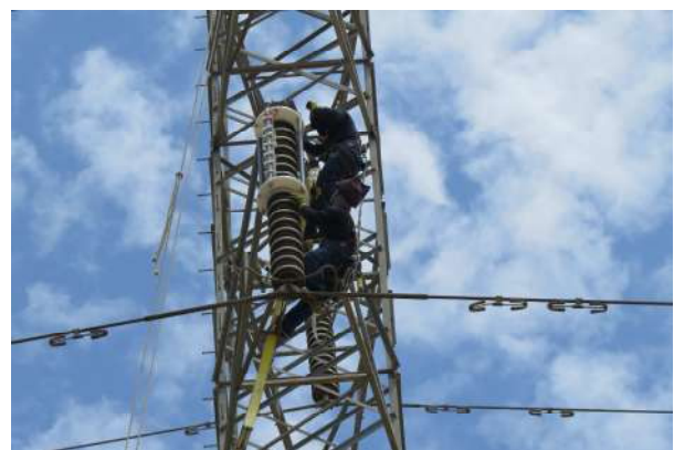
Foto N° 4 Equipo limpiador en la línea Chiclayo-Guadalupe 220kV, Perú.
