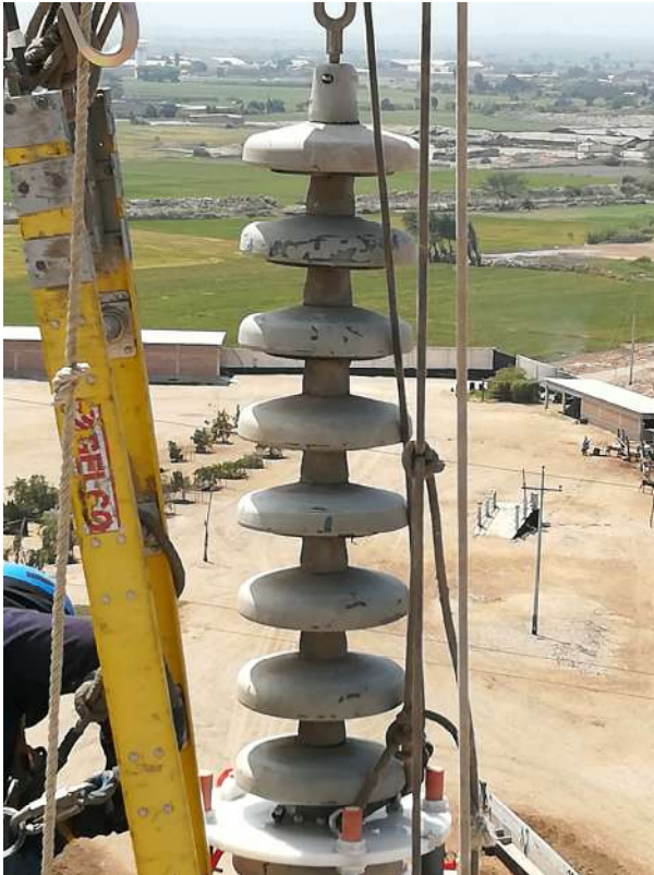
Foto N° 5 Equipo en posicionamiento del segundo tramo de limpieza de la misma cadena
