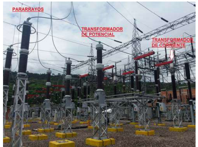
Fig 1. Bahía Típica de Transmisión del GEB
